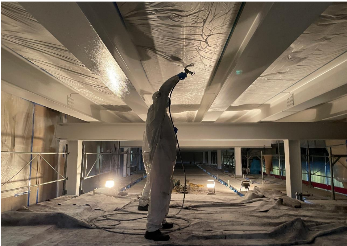
Applikation Brandschutz vor Ort
