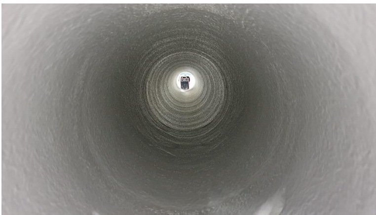
Druckleitung Beschichtung innen und aussen
