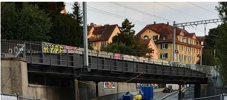
Unterführung fertig beschichtet
