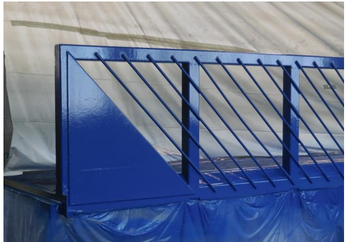
Deckbeschichtung
